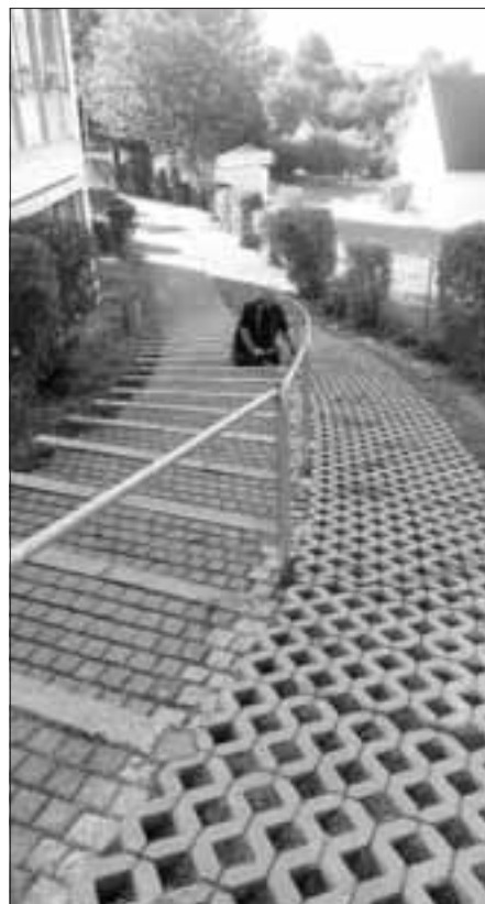
Kurz vor Abschluss der Sanierung
